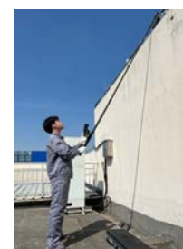
inspección de tejados
