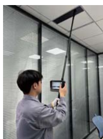
inspección de conductos de techo
